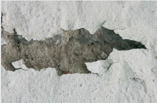
Der aufsteigende Feuchtigkeitsdruck bricht nach außen durch und hinterläßt sich auflösenden Mauermörtel. Die in der Vergangenheit aufgetragene Dispersionsfarbe beschleunigt diesen Prozess.
